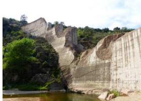
Malpasset dam breakage
